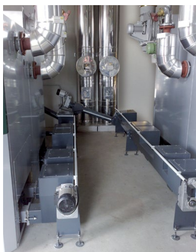
Imaginea prezintă 2 cazane HERZ în cascadă ale căror rezervoare de cenușă sunt conectate via sistem cu melc.
