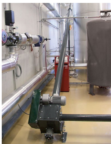
În exemplu, melcul urcător transportă cenușa de la cele 2 sisteme HERZ pe o înălțime de aproximativ 4 m până la un container de cenușă mare de 2m³ ,amplasat în afara sălii cazanelor.
