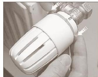
Manșonul de închidere este acum deblocat și poate fi împins în direcția piuliței de fixare, marcajele de reglare de pe roata de acționare devenind astfel vizibile. Dispozitivul de deblocare poate fi îndepărtat.
